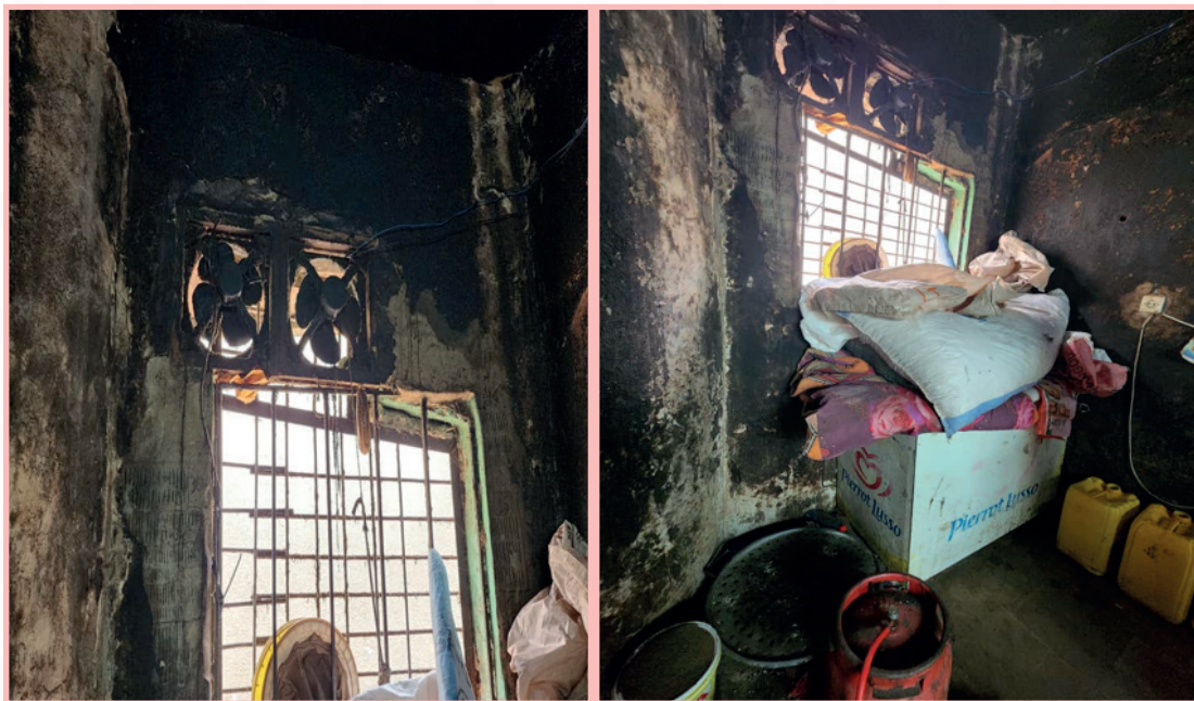
Vue de la cuisine de la MAC de Tivaouane
