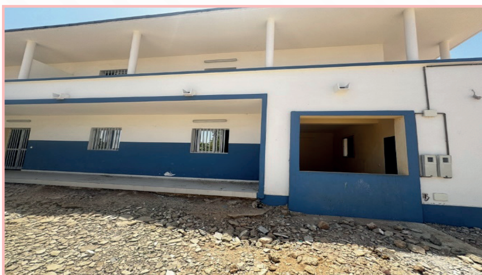
L'ancien CA de Ndorong en cours de réhabilitation
