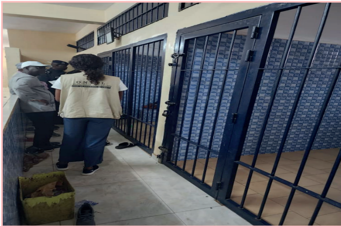
Bloc des trois (03) salles de garde à vue CC Tambacounda
