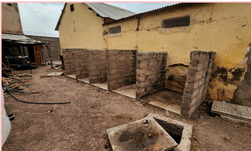
Box de fouille à ciel ouvert de la MAC de Tambacounda
