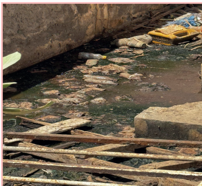
État désolant du CA de Ndong (KL)
