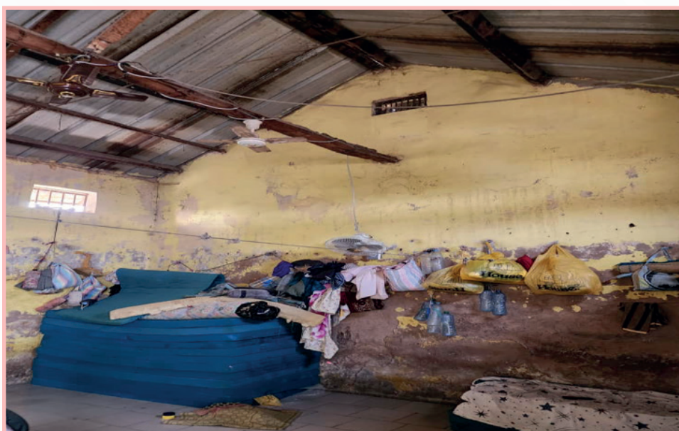
Dortoir avec toiture en zinc à la MAC de Tambacounda
