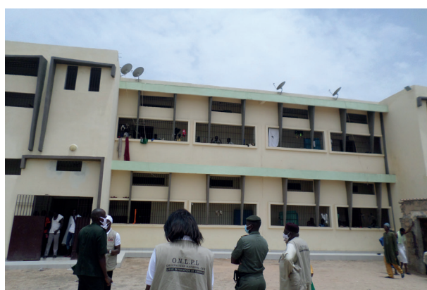
Bâtiment des nouveaux dortoirs du CP de Koutal (09/06/2021)
