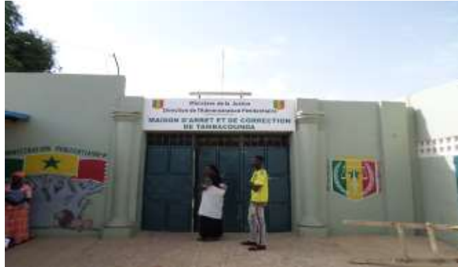
Porte d'entrée principale (PEP) de la MAC de Tambacounda
