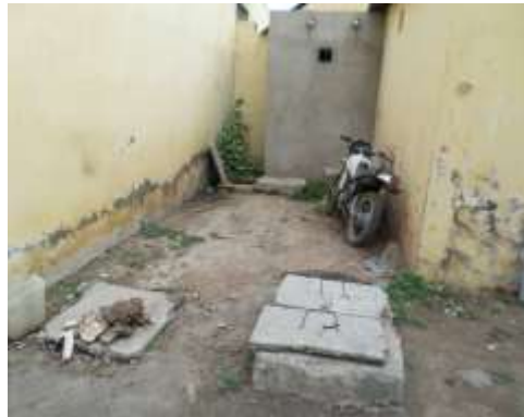
Vue intérieure des regards intérieurs
