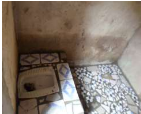
Vue sur le plancher de la cellule disciplinaire
