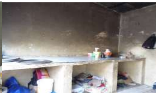
Vue partielle de la cuisine inachevée
