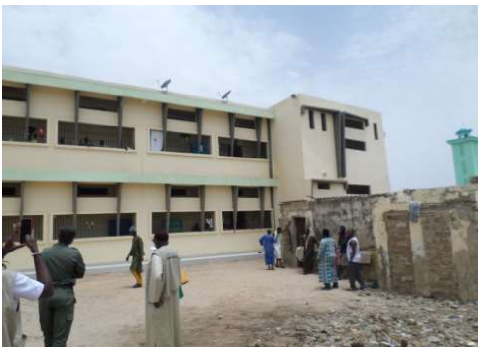
Figure 12: une aile du bâtiment R+1
